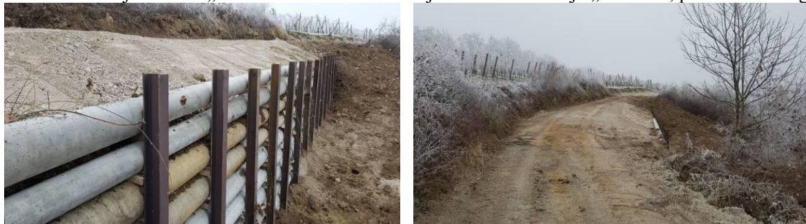
Sanacija klizišta na ŽC Krašić-Vivodina i novi sloj asfalta
