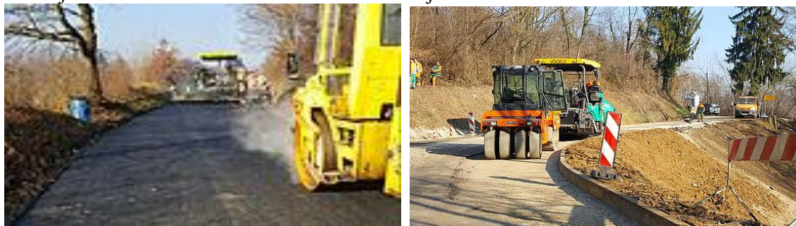
Sanacija klizišta na ŽC Krašić-Vivodina i novi sloj asfalta
